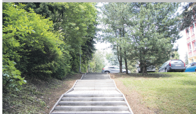
Rekonštrukcia schodov pri Národnom lesníckom centre na ulici J. Kráľa smerom od stanice
